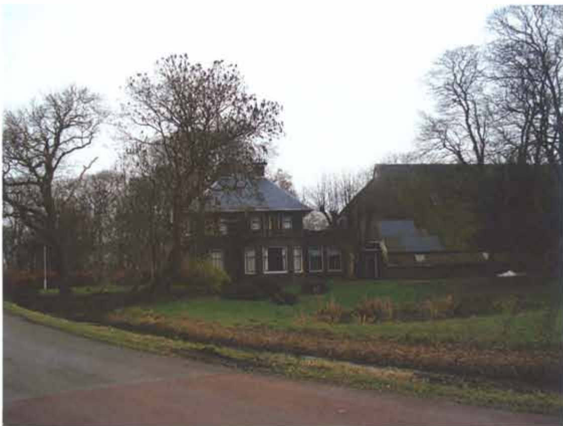
Foto 3.6 Pand met vervorming door zetting in Rasquert
