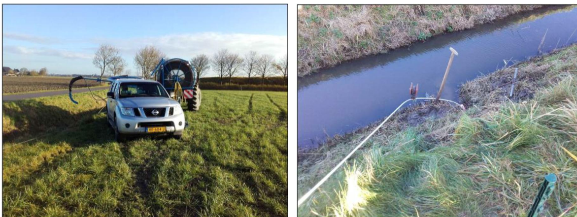
Fig. 2.2. Inbrengen meetsysteem perceel 1 en situatie tijdens meting
